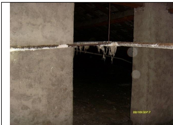
Rivestimento delle tubazioni nel sottotetto del corpo lato palestra
