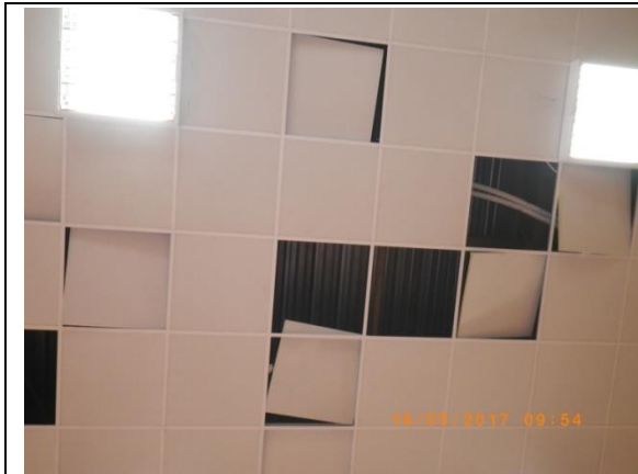
Pannelli dei controsoffitti in FAV nella palestra
