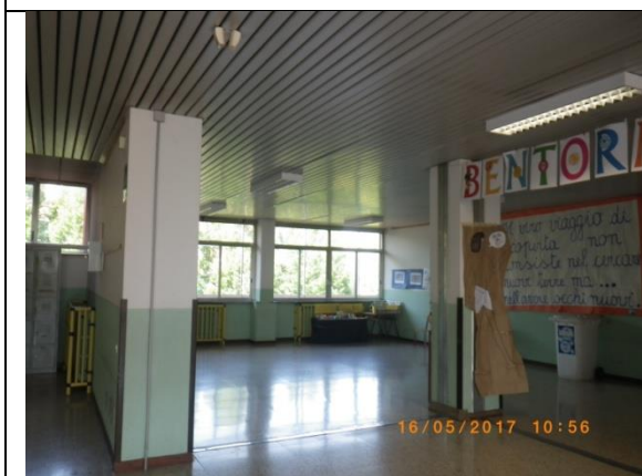
Controsoffitti con materassini in FAV nelle aule e nei corridoi
